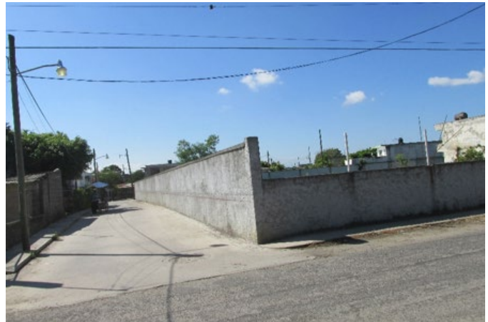
Foto 8: Muro entre las colonias Las Maravillas y 13 de Diciembre Tomada por la autora (17/11/2017)
